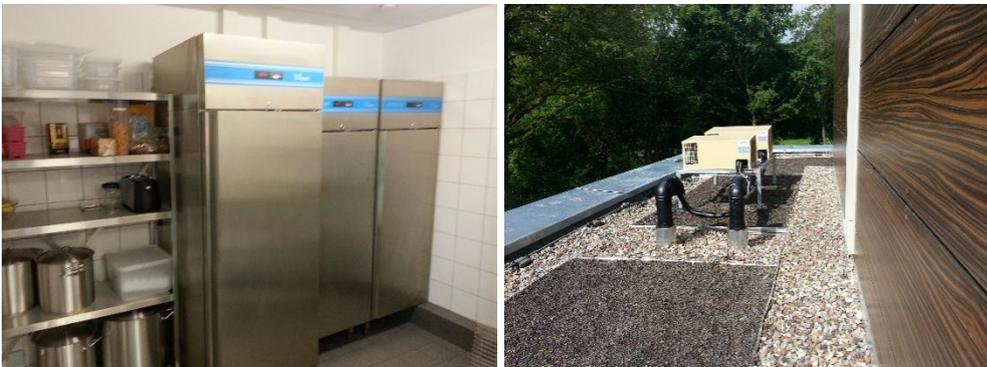
**Abbildung 8** Kühlschränke im Küchenbereich EG (links) und Außenaufstellung der Rückkühlleinheiten auf dem Dach (Kita Robinienweg)
